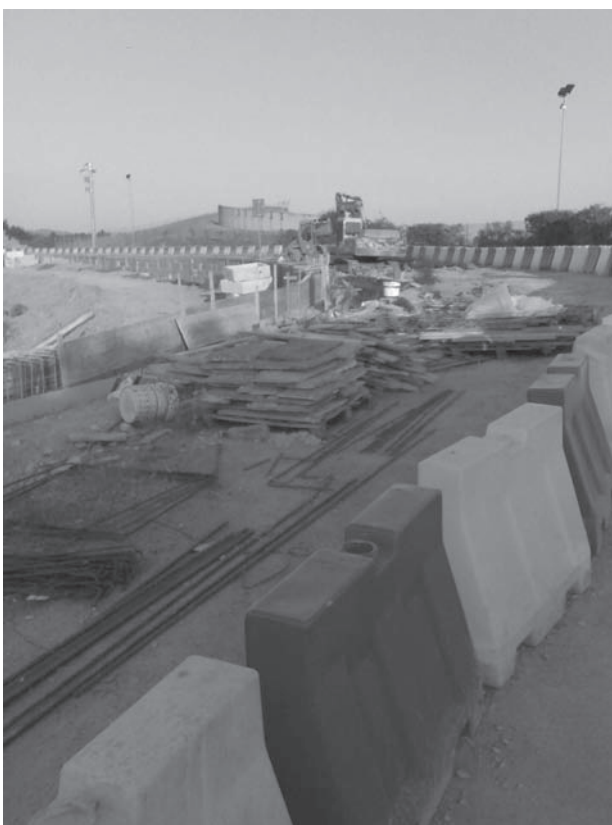
Sabbiuno di Paderno. Un aspetto dei lavori in corso per la sistemazione e il consolidamento del calanco su cui sorge il Memoriale dei Caduti della Resistenza. Sullo sfondo il monumento semicircolare con incastonate i mitri del plotone di esecuzione.
